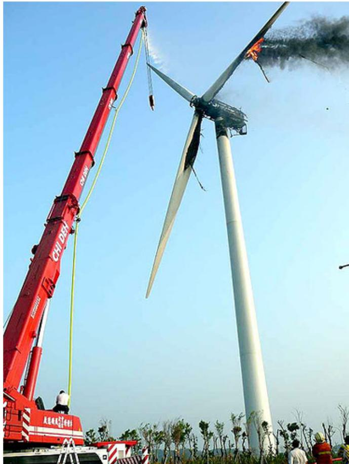
圖 2-2-4 消防吊車滅火系統協助救災示意圖
